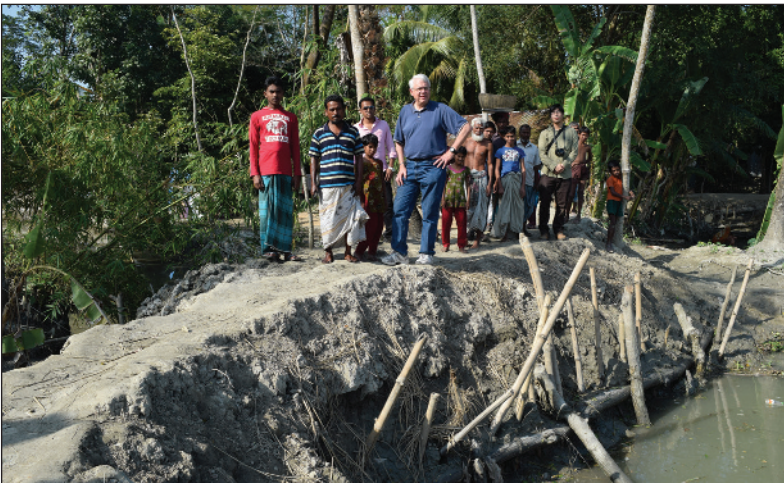
Foto 3: Behelfsmäßige Reparatur eines Deichs durch Dorfbewohner
