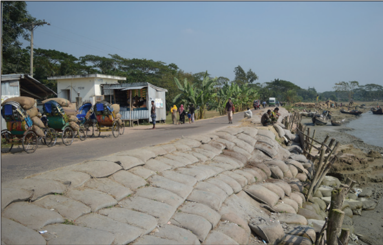
Foto 2: Sicherung des Flussufers und einer Hauptverbindungsstraße mit Sandsäcken, Char Alexander
